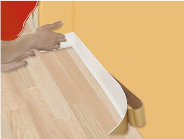
Verlegen der WSL mit selbstklebendem Acrylat-Klebeband
