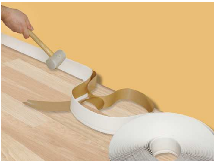
Dauerhafte Befestigung durch versetztes Aufschlagen mit Gummihammer
